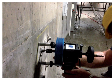
Essai de traction directe sur une pastille en cours (CEREMA)
