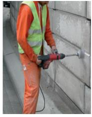
Découpe du parement en béton au droit de l'implantation d'un témoin (Cerema)
