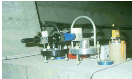
émetteur sur tête de pile (Cerema)
