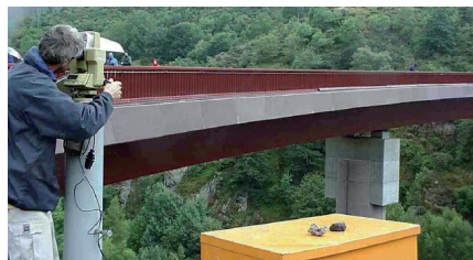
théodolite en station (Cerema)
