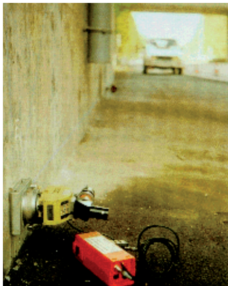
Distancemètre et récepteur en place sur un mur de culée (Cerema)
