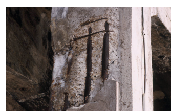
Armatures apparentes et oxydées (lfsttar)
