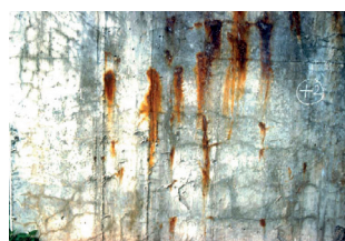
Traces d'oxydation (lfsttar)
