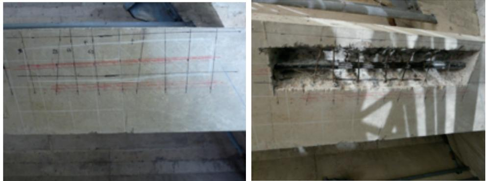
Figure 9 : Réalisation d'une fenêtre au droit d'un câble longitudinal en talon de poutre (Cerema))
