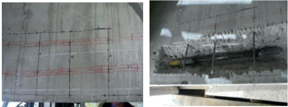
Figure 10 : Réalisation d'une fenêtre au droit d'un câble de précontrainte d'une entretoise intermédiaire (Cerema)
