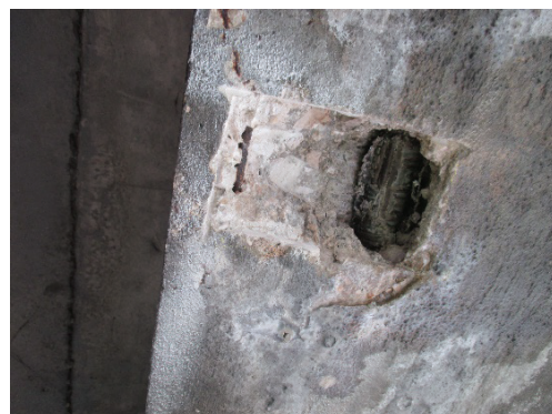
Ouverture d'une petite fenêtre pour sondage de l'état de la précontrainte (Cerema)
