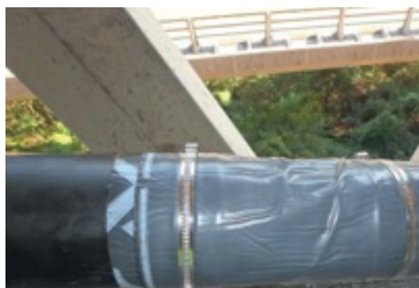
Fermeture provisoire avec protection supplémentaire (photo DGITM/DMR/FCA)
