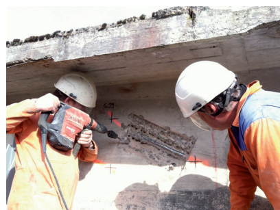
Ouverture d'une fenêtre au droit d'un câble de précontrainte relevé sur une poutre d'un VIPP (Cerema)
