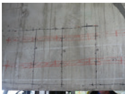
Traçage après détection des armatures internes au béton (Cerema)
