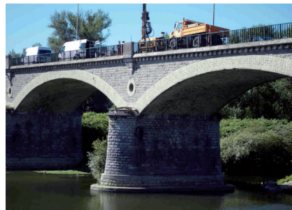
Sondage en cours à l'aplomb d'une pile de pont en maçonnerie (CEREMA)
