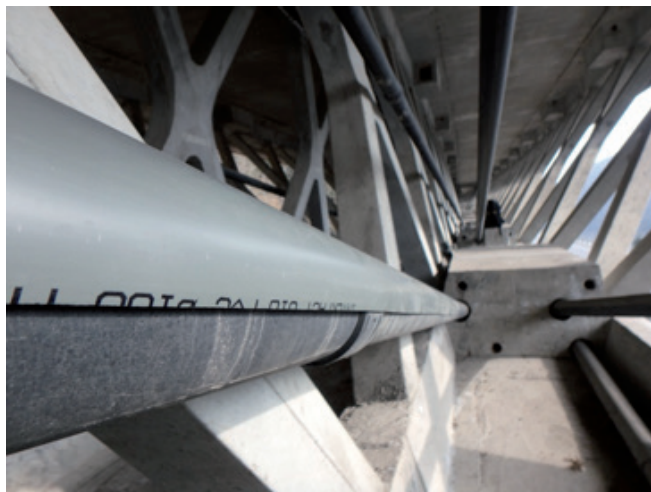
Exemple de gaine positionnée sur un manchon (Cerema)
