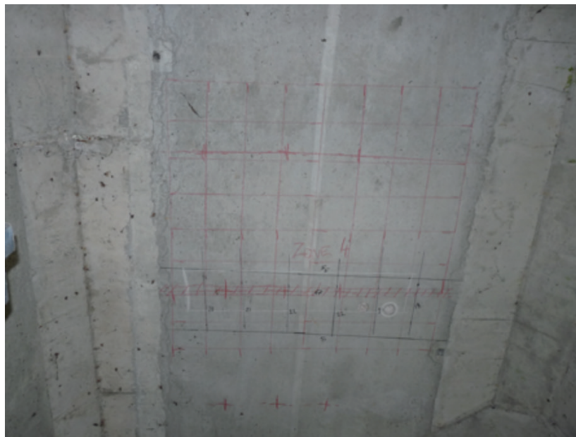
Figure 11 : Zone en intrados de hourdis avec marquage du ferrailage et du câblage par scanner (Cerema)
