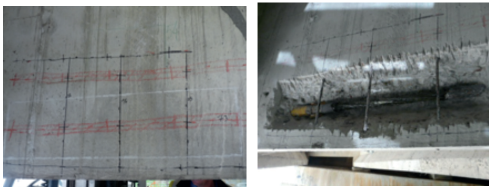
Figure 10 : Réalisation d'une fenêtre au droit d'un câble de précontrainte d'une entretoise intermédiaire (Cerema)
