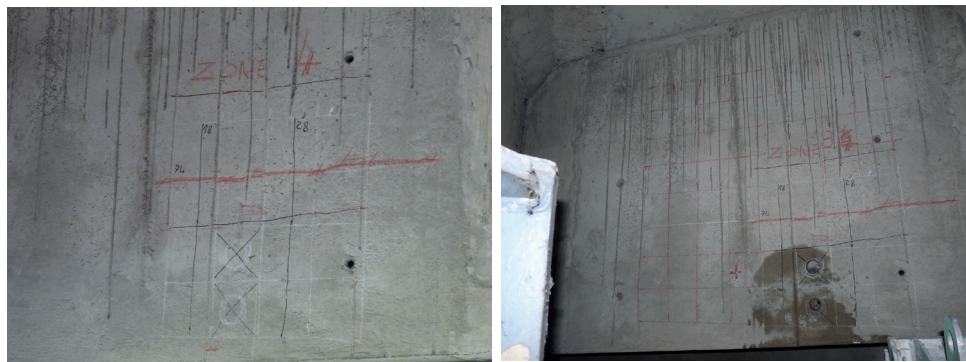
Figure 5 : Zone avant (gauche) et après (droite) les prélèvements de béton. Le câble de précontrainte est tracé en rouge et les aciers passifs en noir (Cerema)
