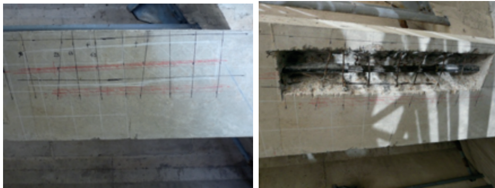
Figure 9 : Réalisation d'une fenêtre au droit d'un câble longitudinal en talon de poutre (Cerema))
